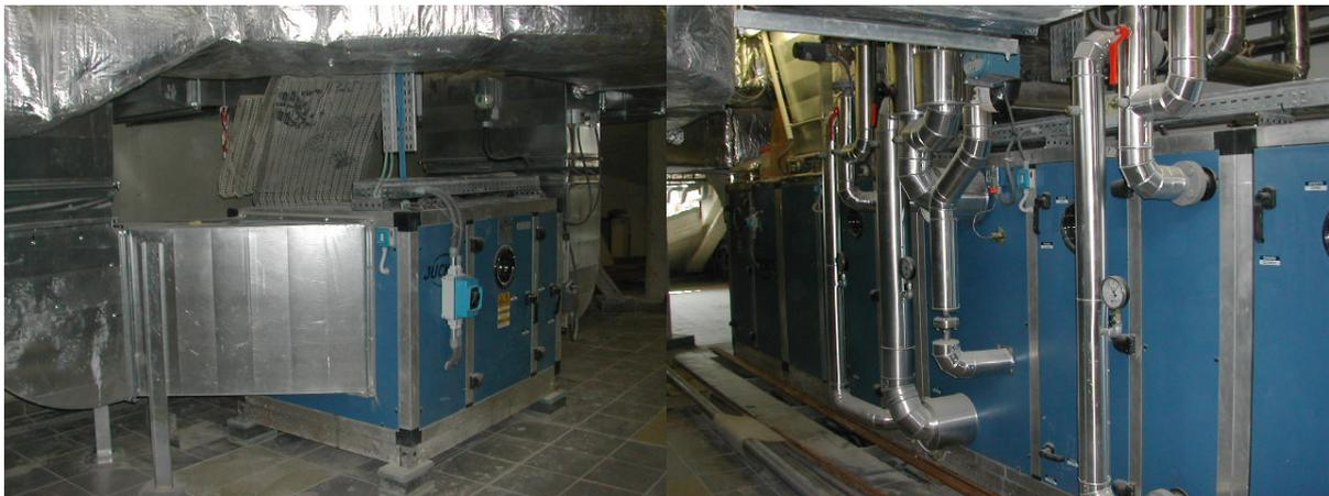
fig.25 – Particolari delle CTA in Soffittone della Cavea
