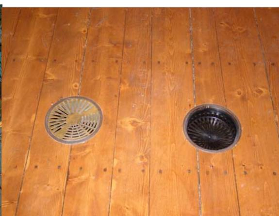
fig.19 – Fasi lavorative in Platea, particolari delle bocchette sottopoltrona
